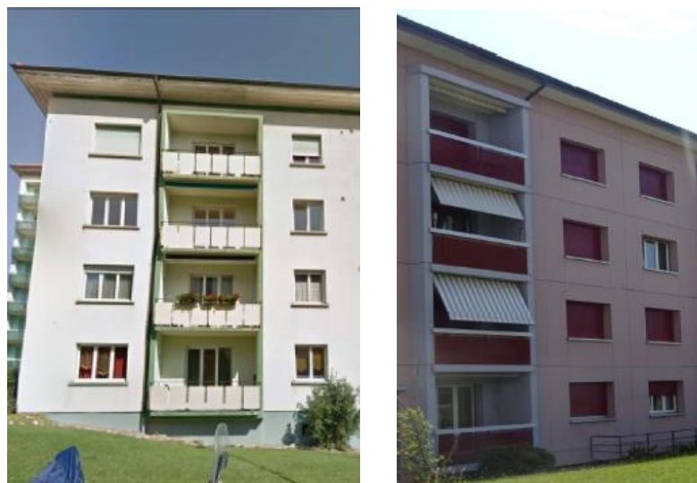
À gauche, la vue avant l'assainissement énergétique, à droite, la vue après ces travaux.
