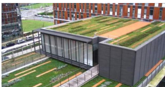
Immeuble du ministère des Finances à Noisy-le-Grand
